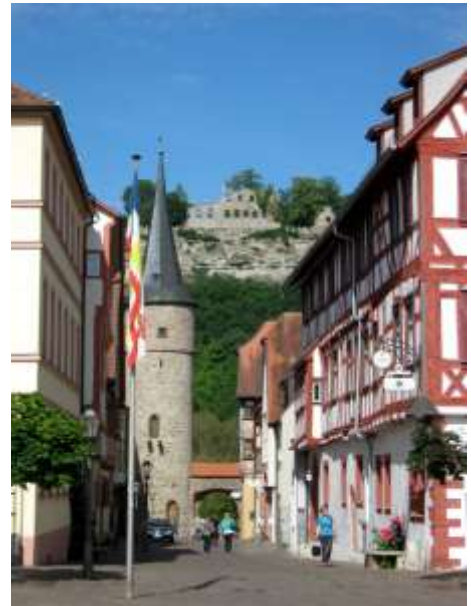
Eine romantische Blickachse Maintor - Burganlage
